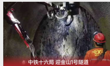
中铁十六局 迎金山1号隧道
