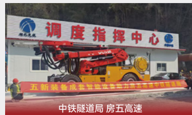
中铁隧道局 房五高速
