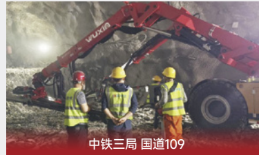
中铁三局 国道109
