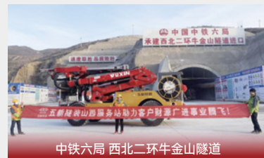
中铁六局 西北二环牛金山隧道
