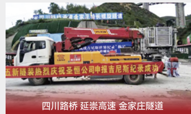
四川路桥 延崇高速 金家庄隧道
