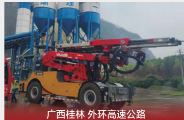
广西桂林 外环高速公路
