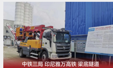
中铁三局 印尼雅万高铁 梁底隧道
