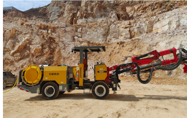
江西新大矿业白云石矿 断面5m×5m
