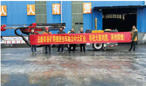
中大矿业贵州重晶石矿 断面2.8m×2.9m
