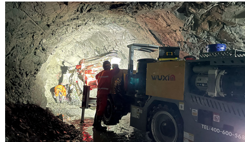
甘肃亚泰矿业铜矿 断面2.8m×3m
