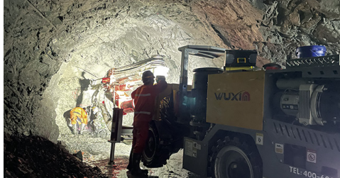
甘肃亚泰矿业铜矿 断面: 2.8m×3.0m
