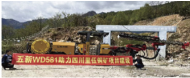
中铁八局四川里伍铜矿 断面: 4.2m×3.8m
