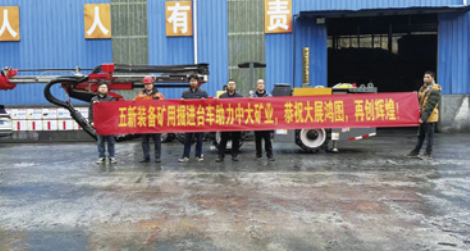
中大矿业贵州重晶石矿 断面: 2.8m×2.9m
