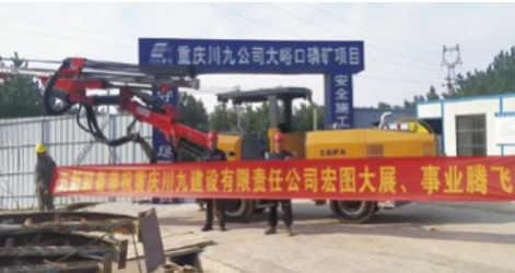
重庆聚能集团大峪口磷矿 断面: 3.8m×4.2m
