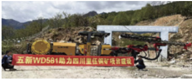
中铁八局四川里伍铜矿 断面: 4.2m×3.8m
