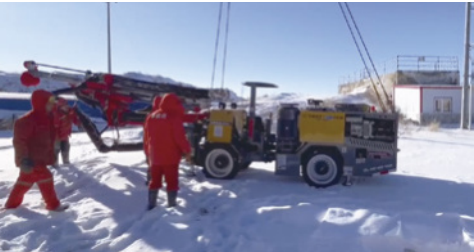
新疆正元国际矿业金矿 断面: 2.7m×2.8m
