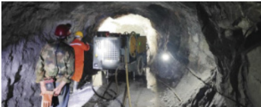
江西新大矿业白云石矿 断面: 5.0m×5.0m
