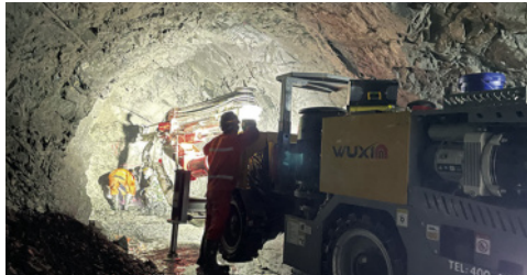
甘肃亚泰矿业铜矿 断面: 2.8m×3.0m
