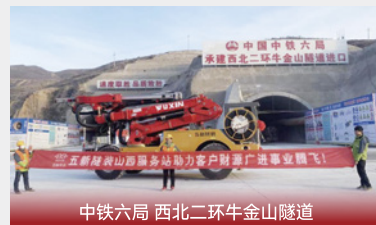
中铁六局 西北二环牛金山隧道
