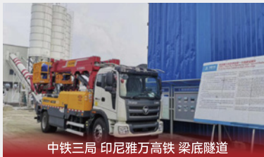
中铁三局 印尼雅万高铁 梁底隧道
