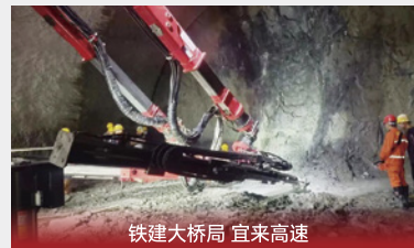
铁建大桥局 宜来高速
