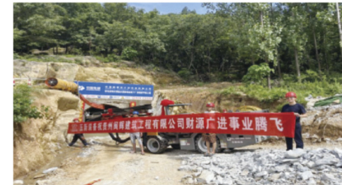
中南院驻马店抽水蓄能电站 断面2.2m×2.5m
