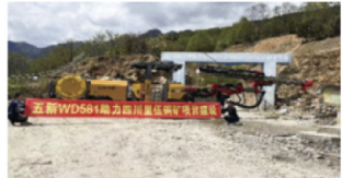
中铁八局四川里伍铜矿 断面4.2m×3.8m
