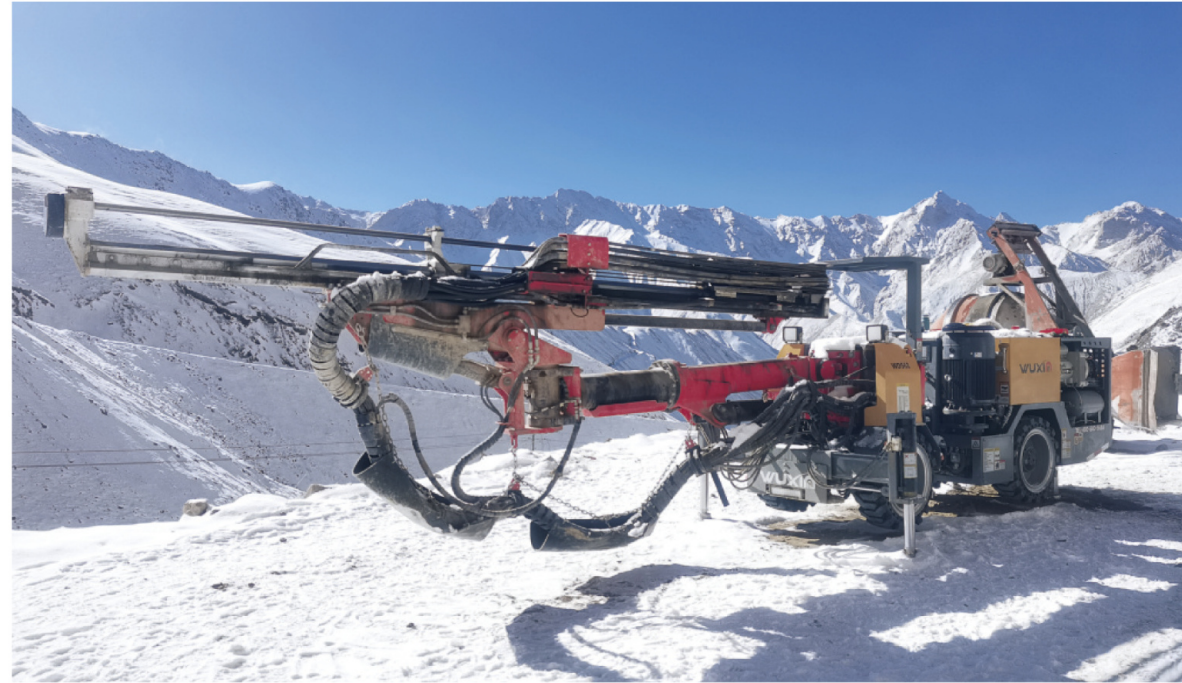
新疆地矿屈库勒克东金铜矿 断面2.5m×3.2m
