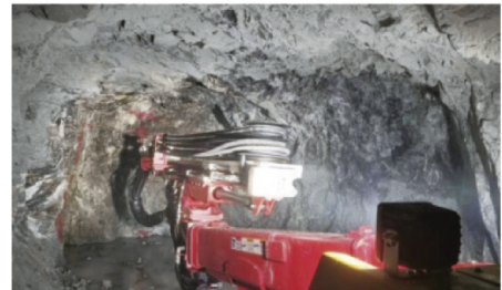
河北阜平抽水蓄能电站勘探洞 断面2.2m×2.5m
