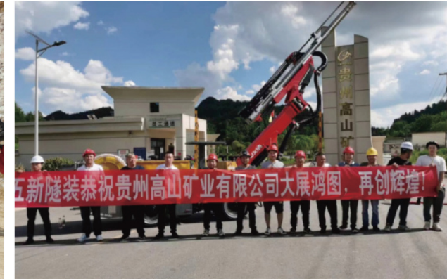
贵州高山矿业磷矿 断面3.7m×4.5m/3.9m×4.9m
