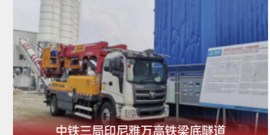
中铁三局印尼雅万高铁梁底隧道
