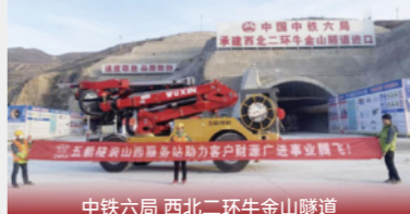
中铁六局 西北二环牛金山隧道
