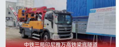
中铁三局印尼雅万高铁梁底隧道
