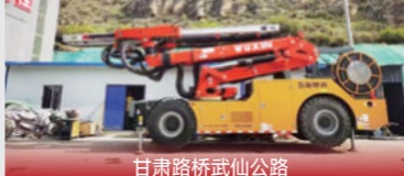
甘肃路桥武仙公路
