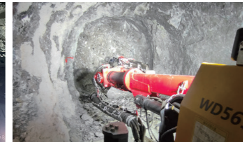
江苏南京银茂铅锌矿业铅锌矿 断面3m×3m
