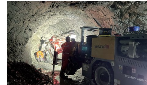
甘肃亚泰矿业铜矿 断面2.8m×3m
