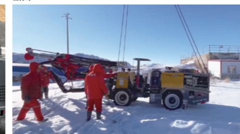
新疆正元国际矿业金矿 断面2.7m×2.8m
