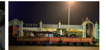
乌拉特后旗东矿有限公司尾矿库 断面3.8m×4.8m
