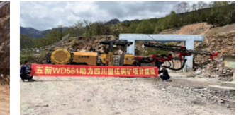
中铁八局四川里伍铜矿 断面4.2m×3.8m
