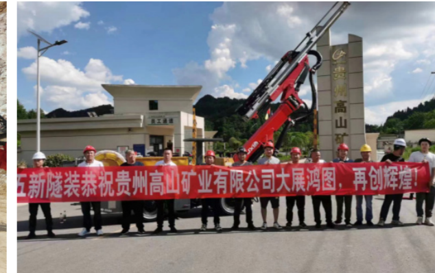
贵州高山矿业磷矿 断面3.7m×4.5m/3.9m×4.9m
