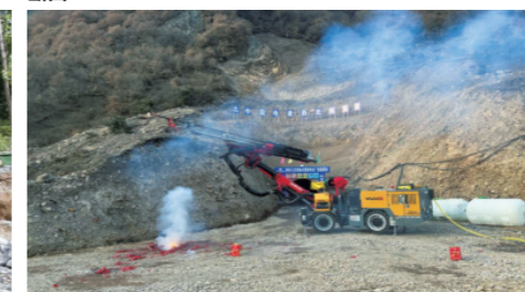
中国电建西北院陕西大庄抽水蓄能电站 断面2.5m×2.5m
