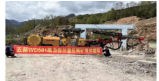
中铁八局四川里伍铜矿 断面4.2m×3.8m
