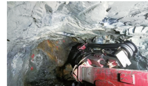
中国电建山西孟县上社抽水蓄能电站 断面2.2m×2.5m
