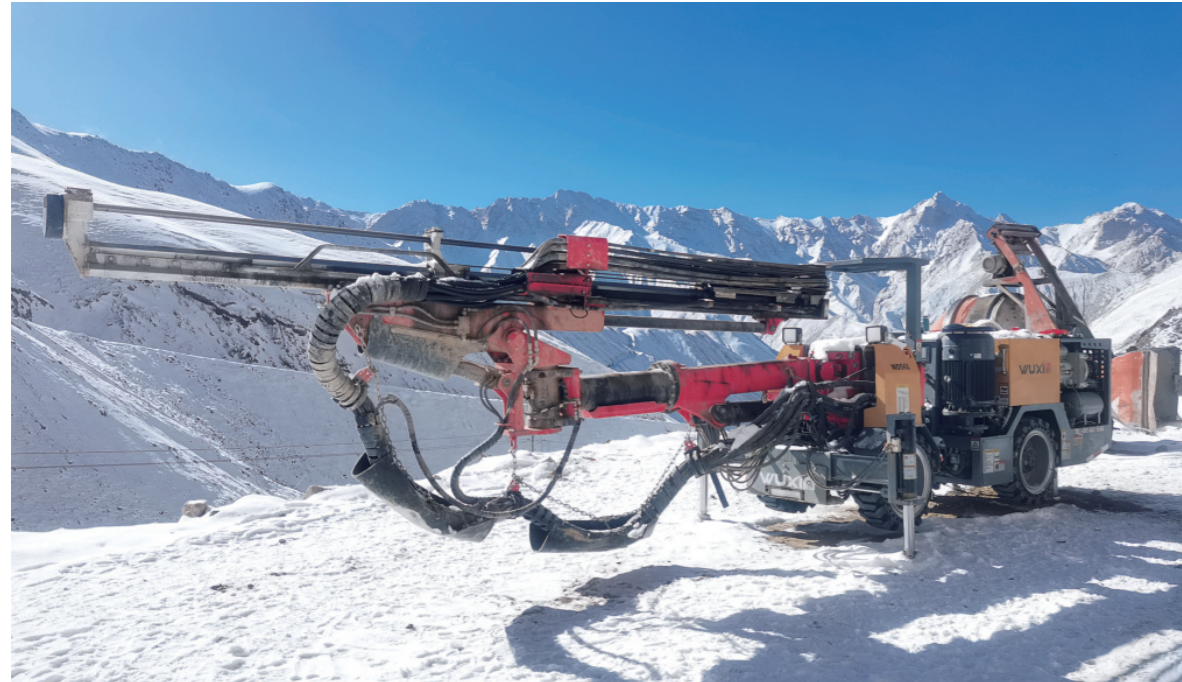
新疆地矿屈库勒东金铜矿 断面2.5m×3.2m
